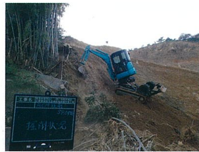
高所機械掘削 (ロック・クライミング掘削)
